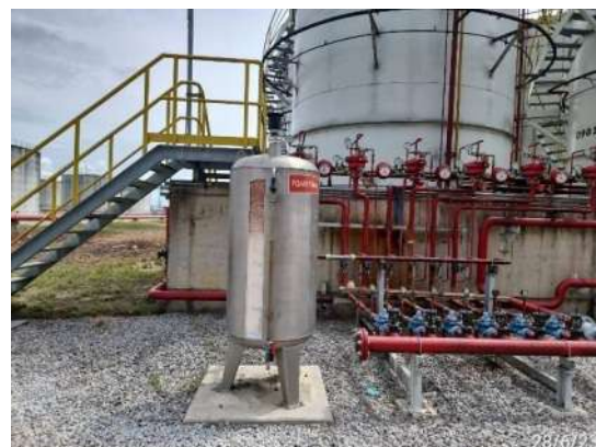
รูปที่ 2-101 ระบบการฉีดโฟมเข้าถังเอทานอล
