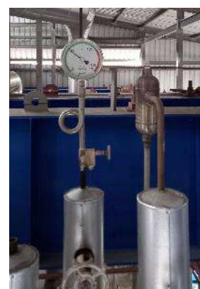
รูปที่ 2-109 หม้อไอน้ำ (ความดัน อุณหภูมิ อัตราการไหล ระดับน้ำ)
