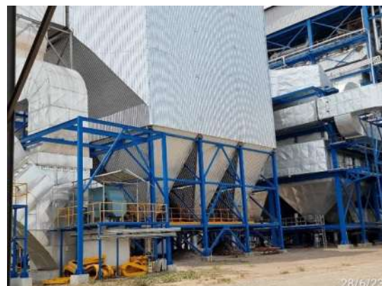
รูปที่ 2-18 เครื่องดักฝุ่นแบบไฟฟ้าสถิต (Electrostatic Precipitator; ESP)
