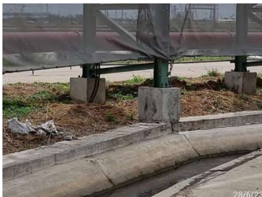
วางระบายน้ำฝนบริเวณพื้นที่ลานกองขาน้อย และกองกากตะกอนกรองน้อย
