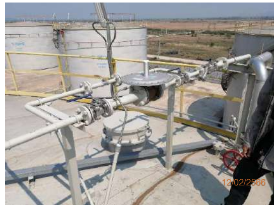
รูปที่ 2-99 Pressure Control Valve
