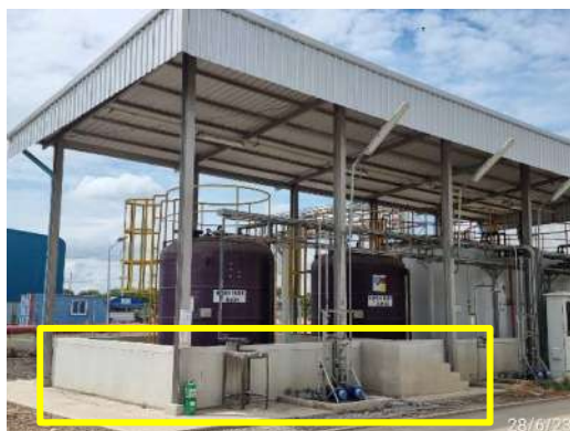
รูปที่ 2-92 การสร้างคันคอนกรีต บริเวณถังเก็บสารเคมี
