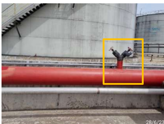
รูปที่ 2-102 ระบบหัวฉีดน้ำดับเพลิง รอบพื้นที่ถังเอทานอล
