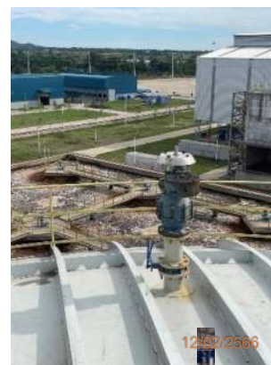
รูปที่ 2-107 อุปกรณ์กันไฟไหลย้อนกลับ
