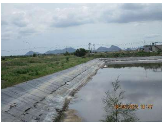
รูปที่ 2-39 การปูกันบ่อด้วยพลาสติก HDPE
