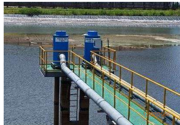
รูปที่ 2-44 เครื่องตรวจวัดดีโอแบบต่อเนื่อง (DO Online)
